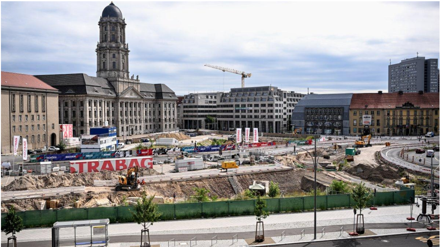
Blick auf die Baustelle am Molkenmarkt in Berlins historischer Mitte.
