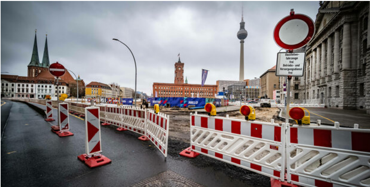
Hier soll es irgendwann mal schön aussehen: Baustelle am Molkenmarkt in Berlin-Mitte
