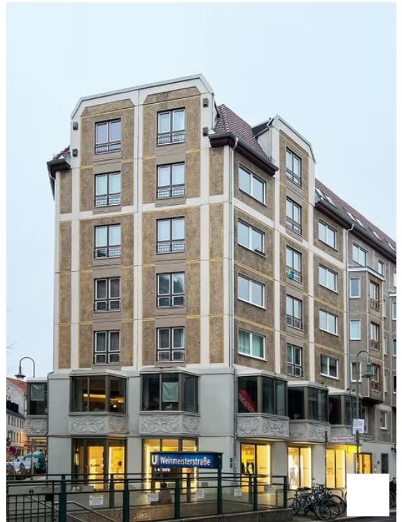
Eckgebäude Weinmeisterstr. 8 / Neue Schönhauser Str. 1
