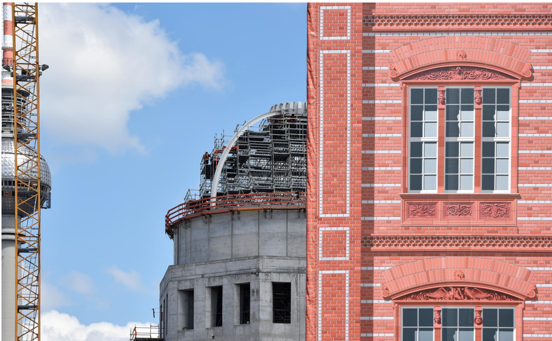
Detail des Rohbaus des Berliner Schlosses neben der Schauffassade der Schinkelschen Bauakademie © Alliance / dpa / Jens Kalaene
