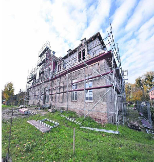
Das Gutshaus im Potsdamer Ortsteil Satz Korn während der Sanierung. Foto: Ottmar Winter PNN/Ottmar Winter PNN Von Benjamin Lassiwe
