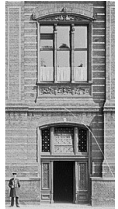
Ebenerdige Tordurchfahrt (1911, Mesßbildanstalt
