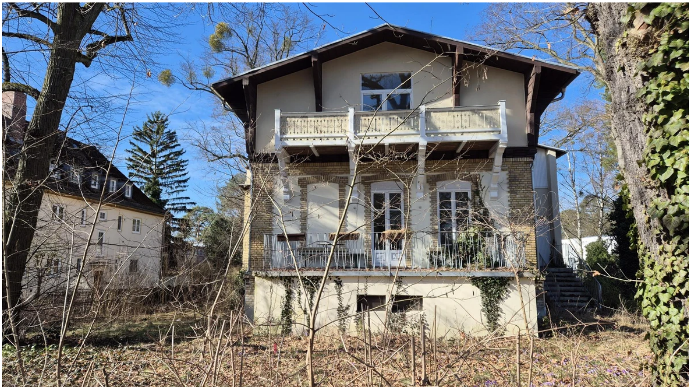
Der Vorgarten ist verwildert, die kleinen roten Klötzchen für den Neubau sind kaum zu sehen.
