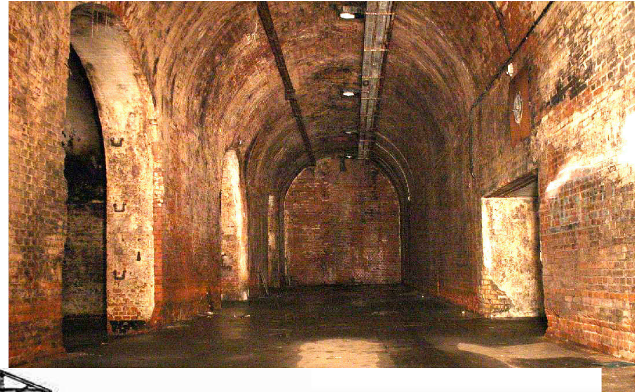
Lagerkeller der Bötzw-Brauerei (Berlin, Prenzlauer Berg)
