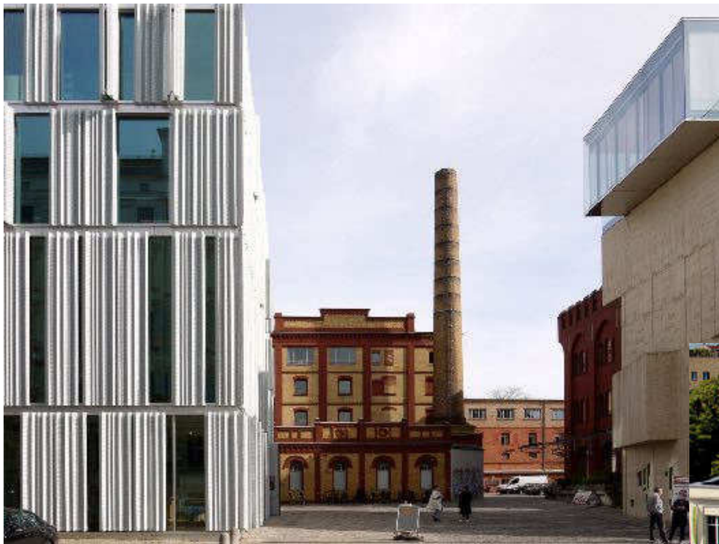
Die Christinenstraße bietet den besten Blick auf die moderne Architektur neben historischen Brauereigebäuden
