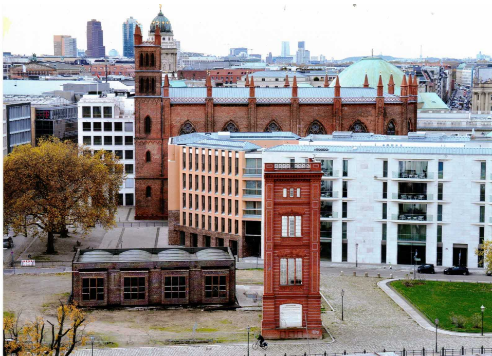
Nord-Ost-Ecke der Bauakademie. Dieses Foto ersetzt das Motiv-ähnliche Foto der Tagesspiegelveröffentlichung. Foto: Arno Pluschke
